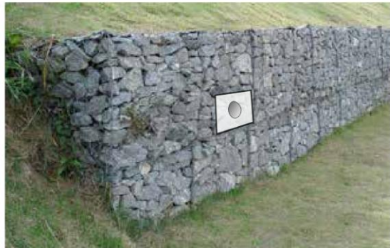
Raccorder ses réseaux dans les règles de l'art pour pérenniser les ouvrages et aménagements de la ZAE des Vergeras
